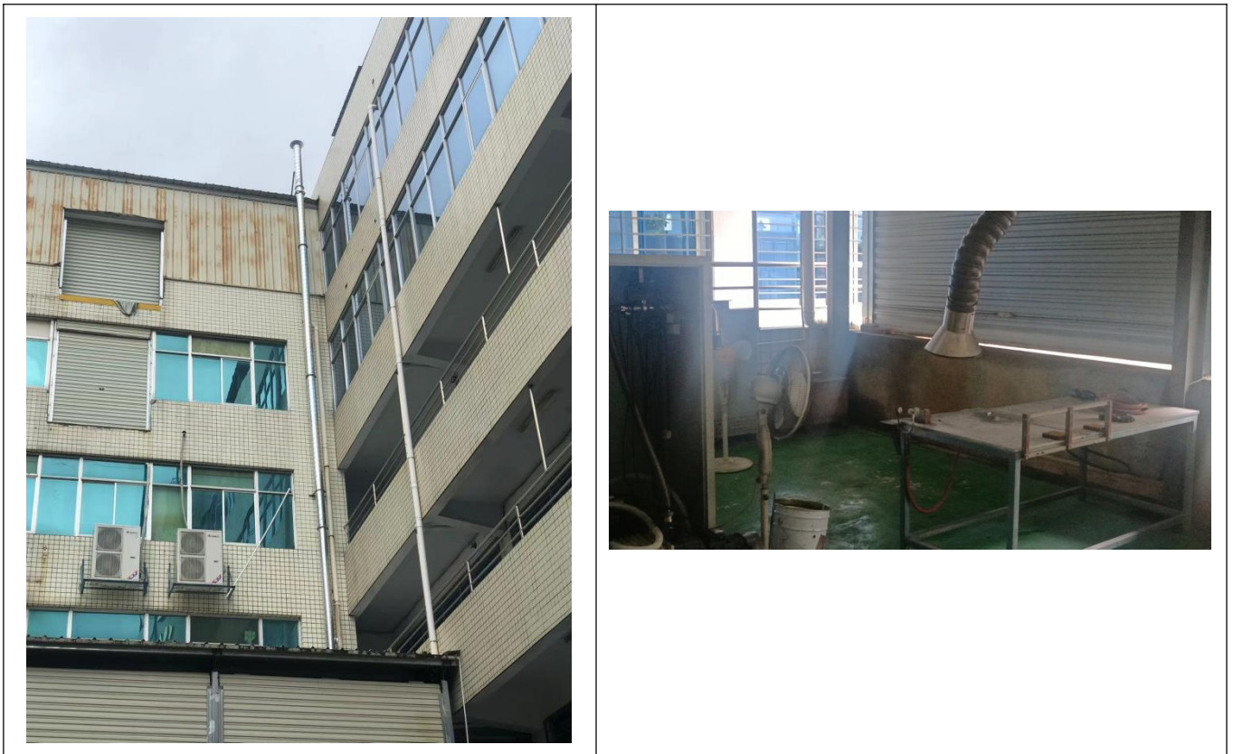
图 4-2 燃料废气排气筒照片
